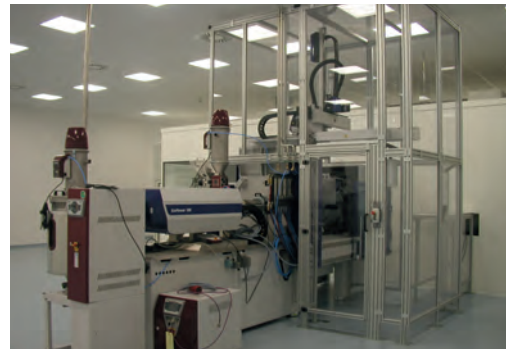
Spritzgießanlage / Injection moulding machine
